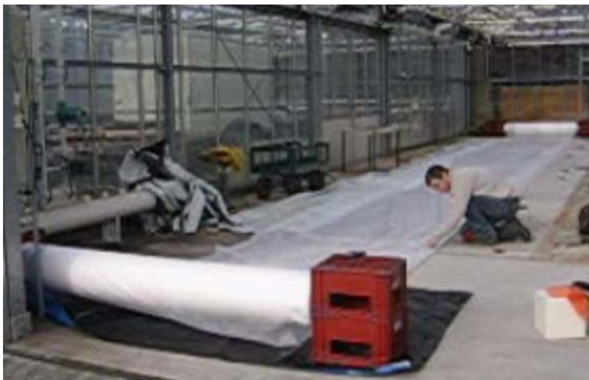
Photo 1 © Inra/G. Roussel : préparation du « boyau » par agrafage et enroulement sur cylindre
