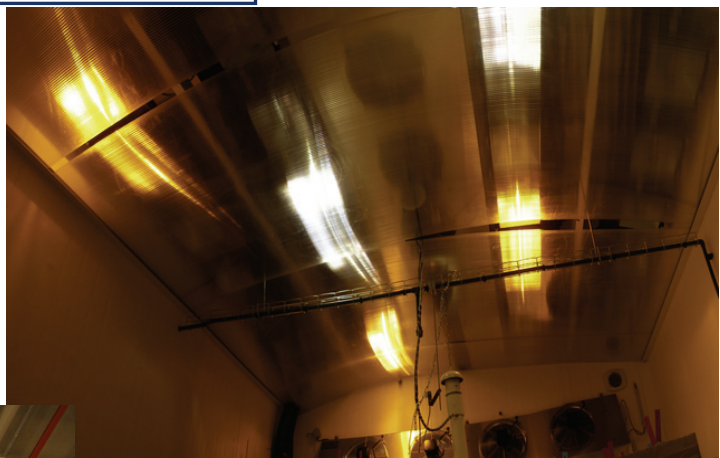
Figure 11 : faux-plafond en matériau plastique translucide de la chambre de culture A
