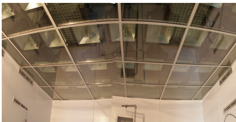
Figure 1. 4 : chambre de culture D (35 lampes à décharges 400W)
