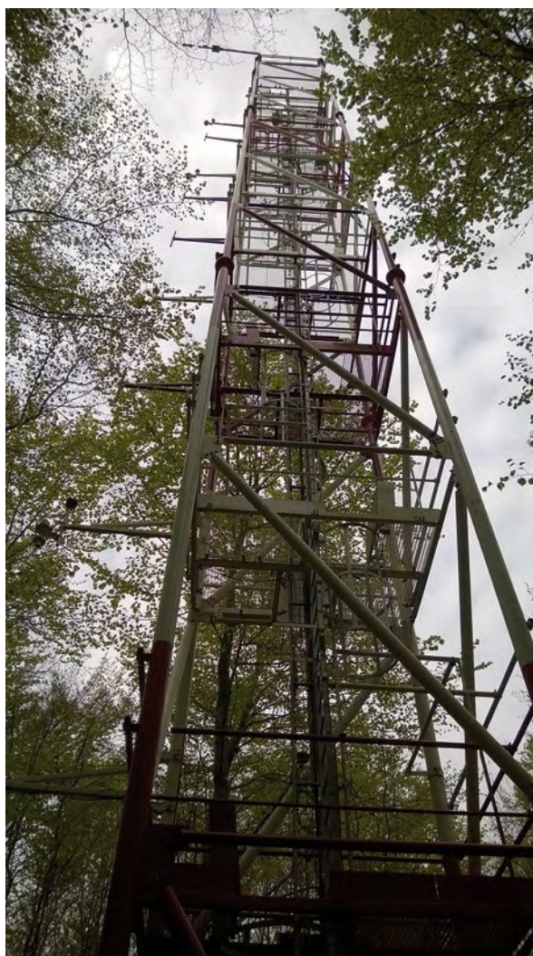
Figure 1. Tour à flux en forêt domaniale de Hesse (57) (photo : P. Gross)
